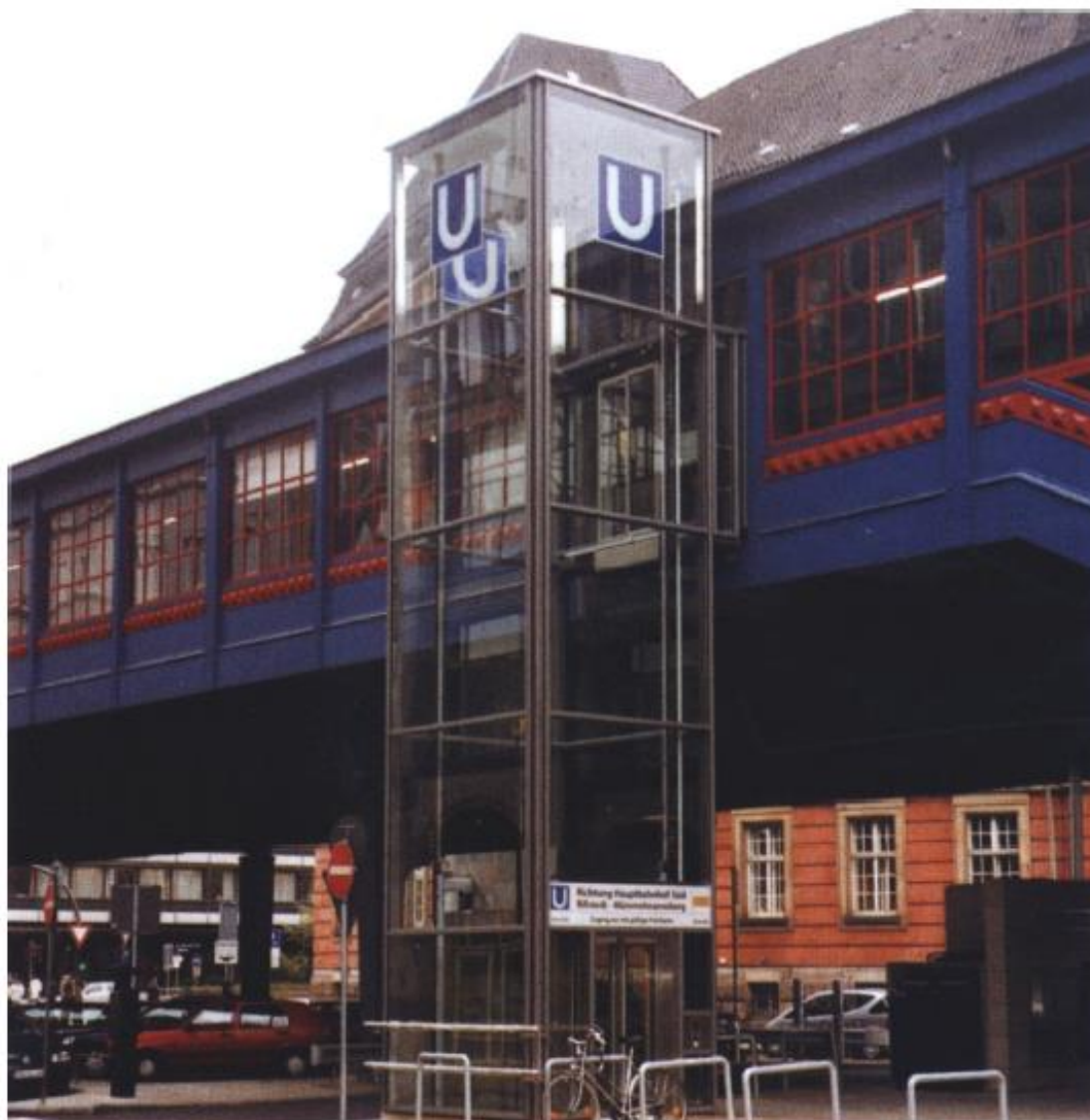
FIGURA A.30 Ascensor externo que permite el acceso a una estación en un nivel superior
