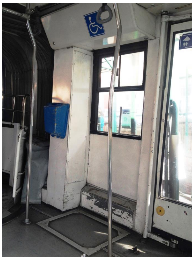
FIGURA A.18 (Inadecuado) Plaza reservada para personas con silla de ruedas sin accesorios de sujeción y apoyos de seguridad
