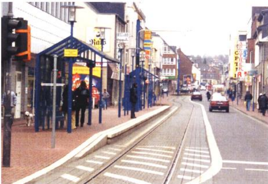
FIGURA A.16 (Adecuado) Parada de autobús y tranvía que proporcionan un acceso llano
